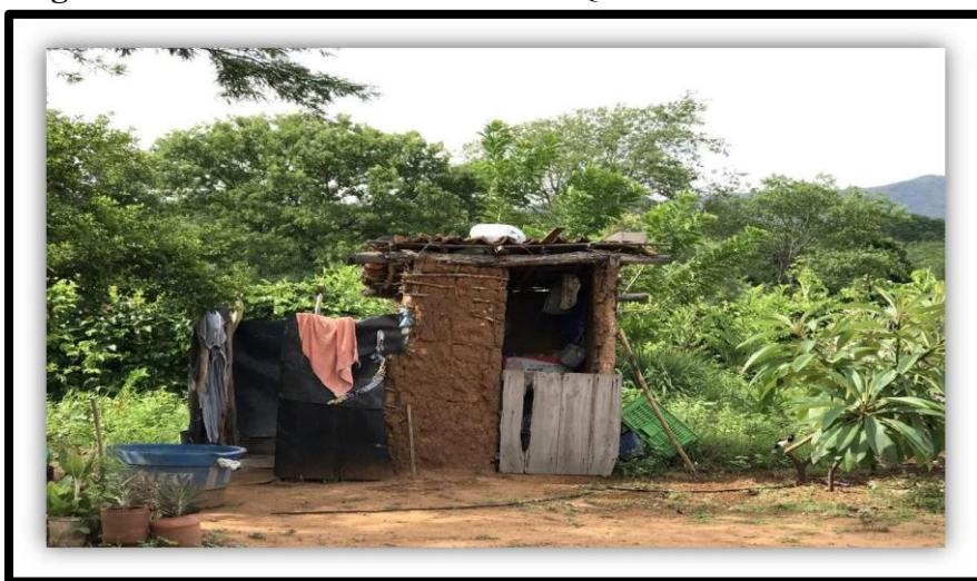
Figura 26 – Banheiro na Comunidade Quilombola de Santana/PE
