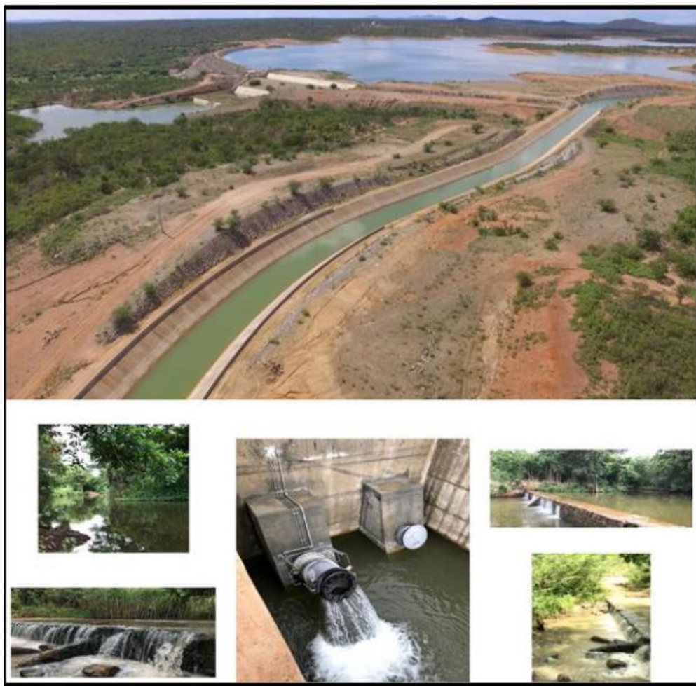
Figura 32 – Barragem Mangueira com comporta aberta com fluxos de água para o Riacho Grande, na Comunidade Quilombola de Santana/PE
